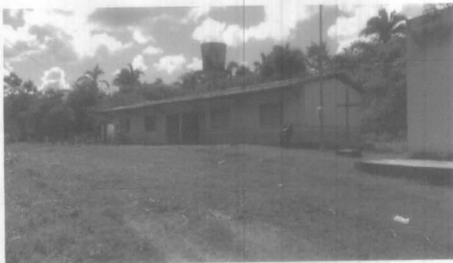
Imagem 2 – pintura externa da fachada Fonte: Autora – 2023
