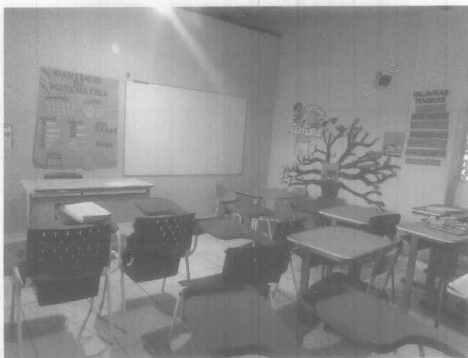
Imagem 4 – pintura geral da área interna, contra de piso e contra piso e recuperação de ponto elétrico.
