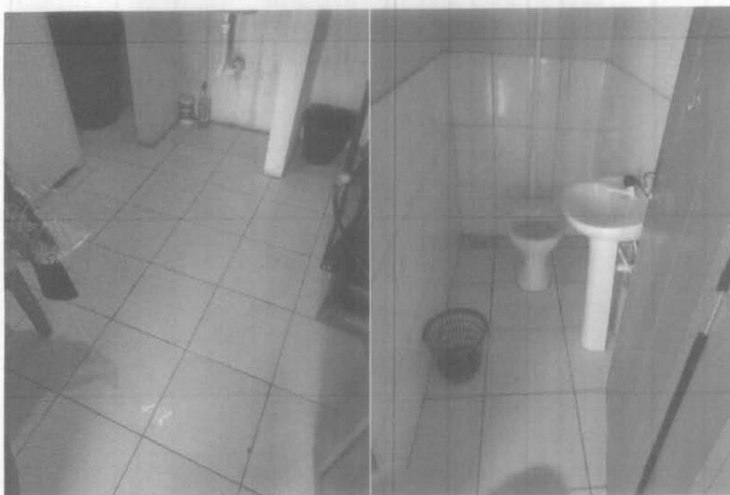
Imagem 3 – pintura interna, revestimento e acessórios sanitários. Fonte: Autora – 2023
