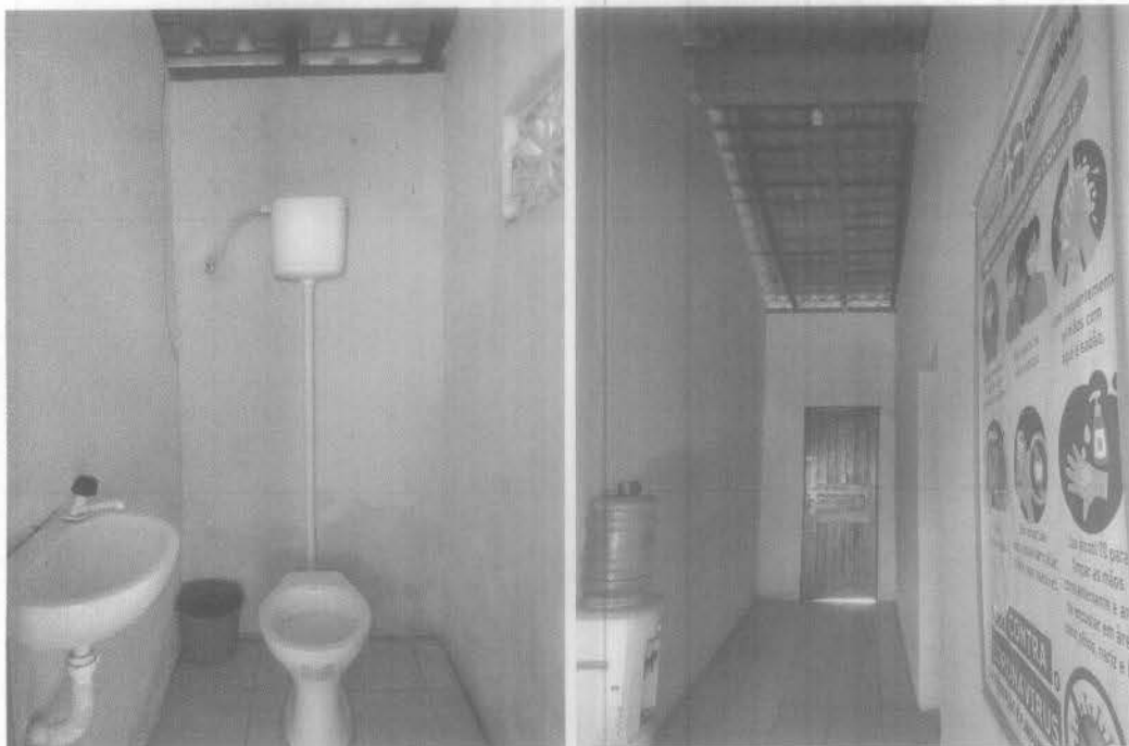
Imagem 2 – recuperação de ponto sanitários e hidráulicos, instalação de vaso e lavatório, pintura interna Fonte: Autora – 2023
