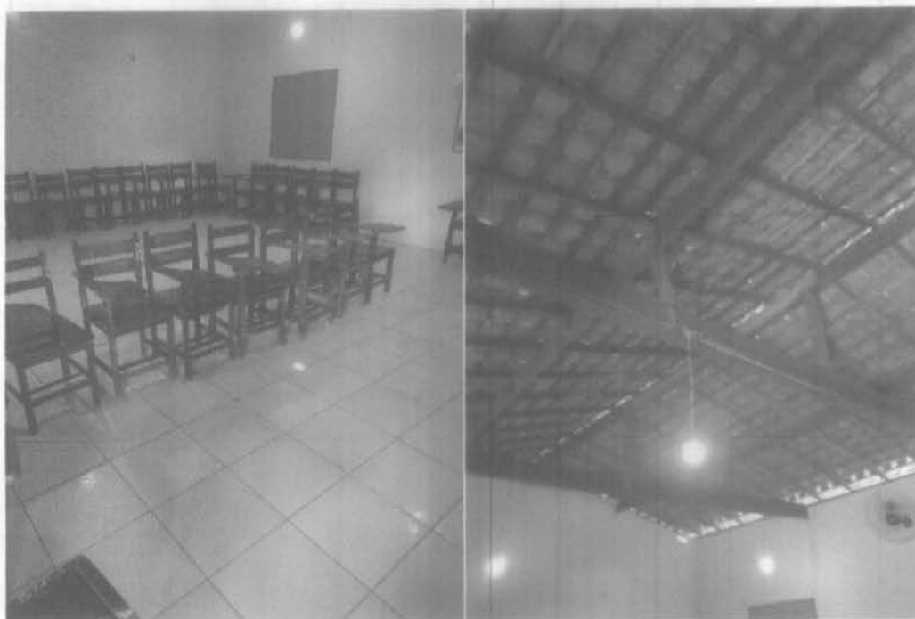
Imagem 4 – pintura interna, retelhamento, iluminação e revestimento.
