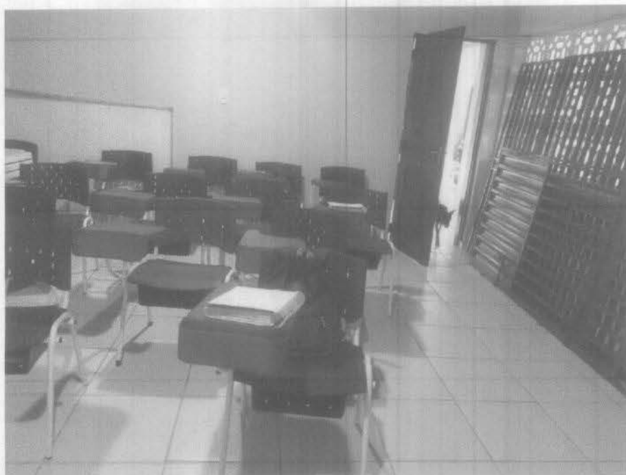
Imagem 3 – pintura geral da área interna, contra de piso e contra piso e instalação de portas e recuperação de ponto elétricos.
