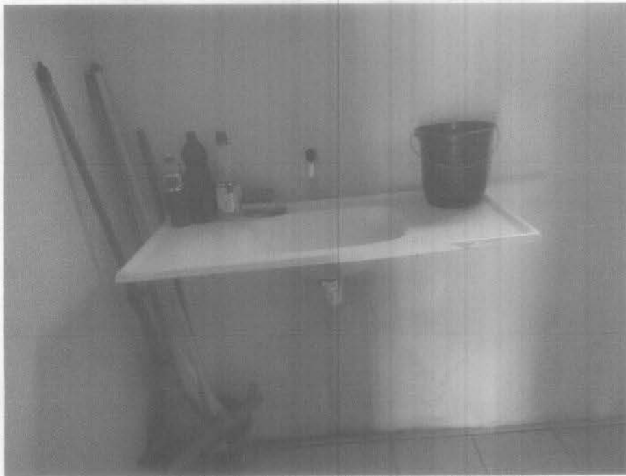
Imagem 4 – instalação da pia e ponto hidráulico, pintura interna.
