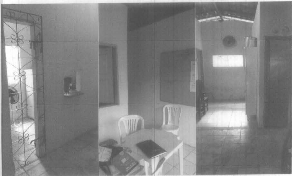
Imagem 4 – pintura interna, instalação de gradil e pintura de esquadrias.
