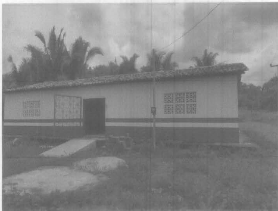
Imagem 1 – Pintura da fachada, recuperação do telhado com substituição de madeira Fonte: Autora – 2023
