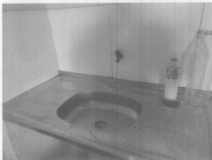
Imagem 4 – instalação de pia inox da cozinha e revestimento na parede. Fonte: Autora – 2023
