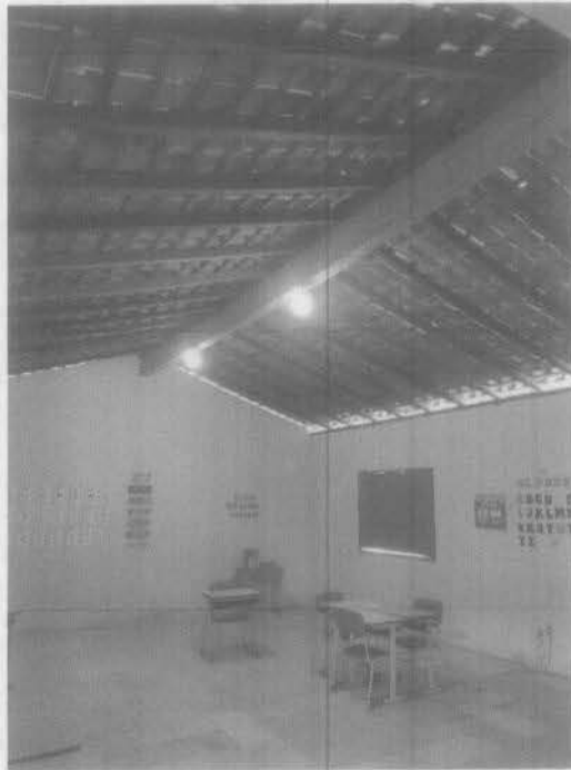
Imagem 3 – pintura geral, retelhamento Fonte: Autora – 2023
