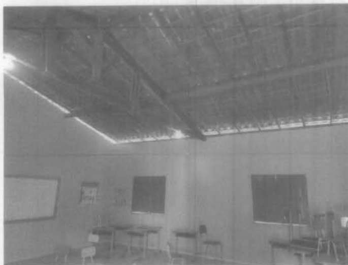
Imagem 3 – pintura interna e pintura das esquadrias, retalhamento Fonte: Autora – 2023
