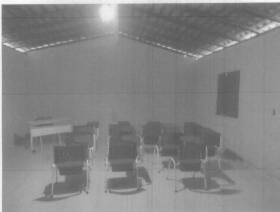
Imagem 3 – pintura geral, retelhamento e recuperação e substituição do piso cerâmico.
