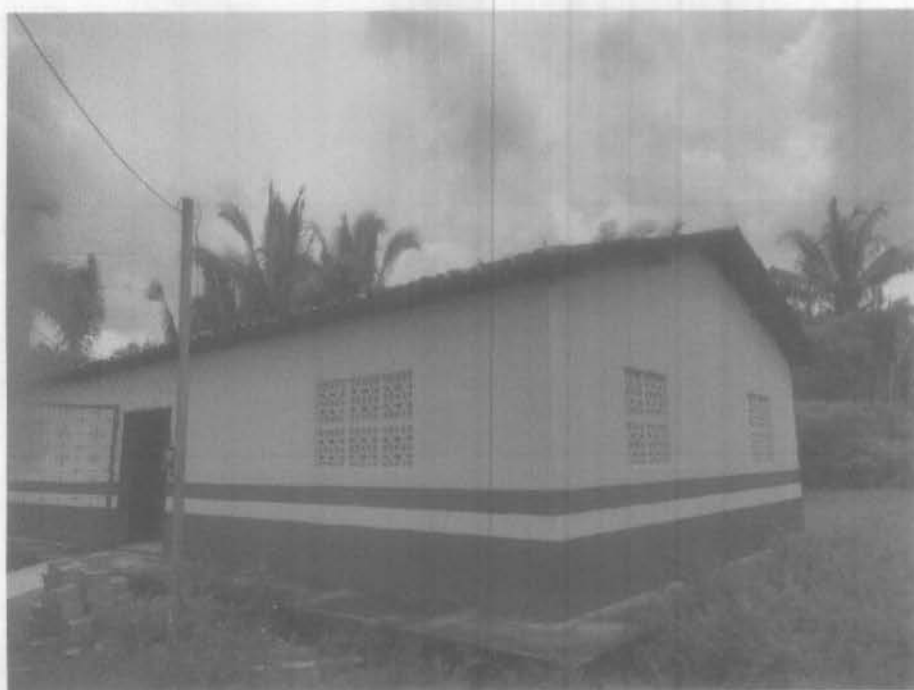
Imagem 2 – Pintura da fachada, recuperação do telhado com substituição de madeira Fonte: Autora – 2023
