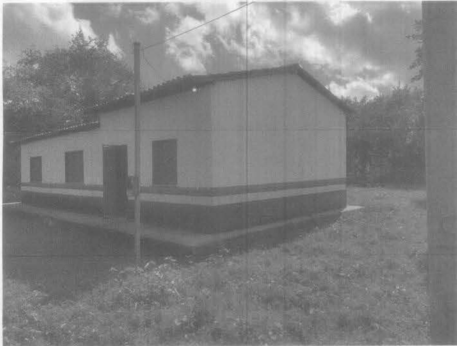
Imagem 1 – Pintura da fachada, recuperação telhado com substituição de 50% de madeira Fonte: Autora – 2023
