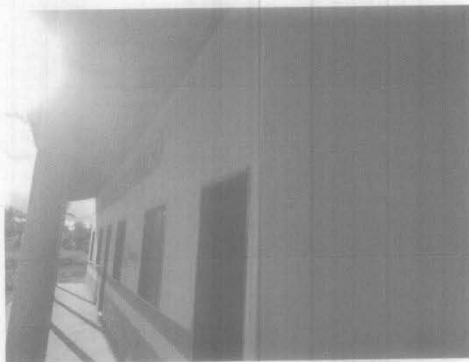
Imagem 2 – pintura externa da fachada Fonte: Autora – 2023
