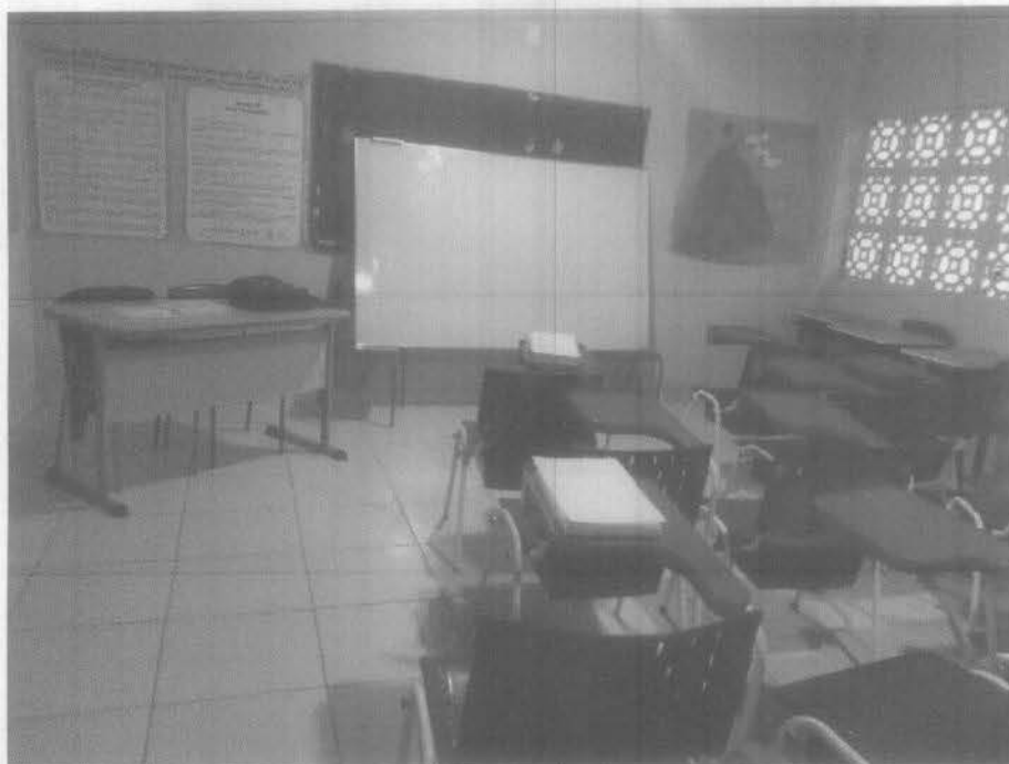
Imagem 5 – pintura geral da área interna, contra de piso e contra piso Fonte: Autora – 2023
