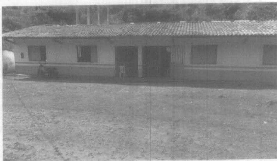
Imagem 1 – pintura da fachada, retalhamento. Fonte: Autora – 2023
