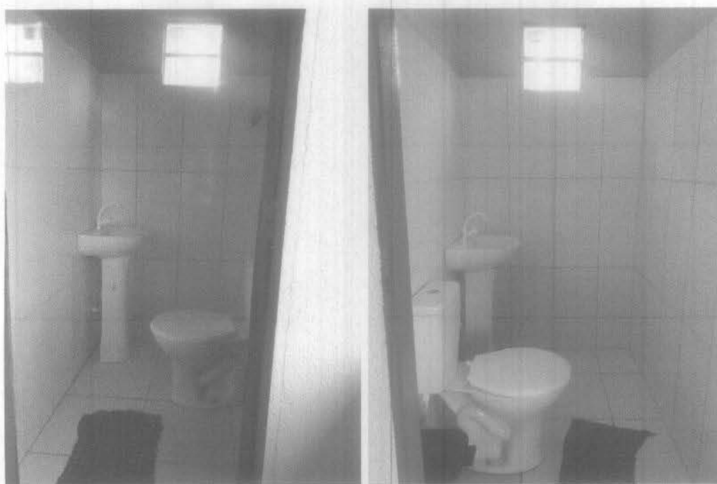
Imagem 6 – recuperação de ponto sanitários e hidráulicos, instalação de vaso e lavatório Fonte: Autora – 2023
