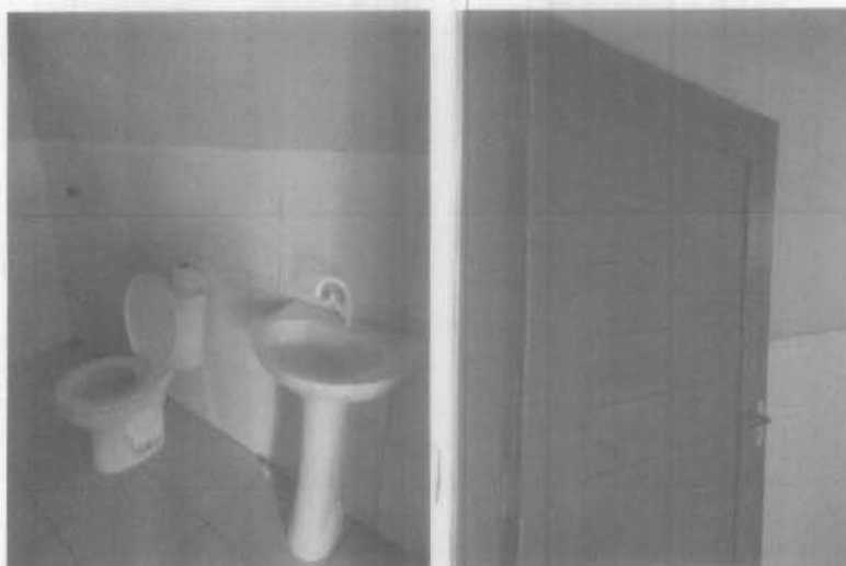
Imagem 4 – instalação de bacia sanitário e lavabo, pintura de esquadrias Fonte: Autora – 2023
