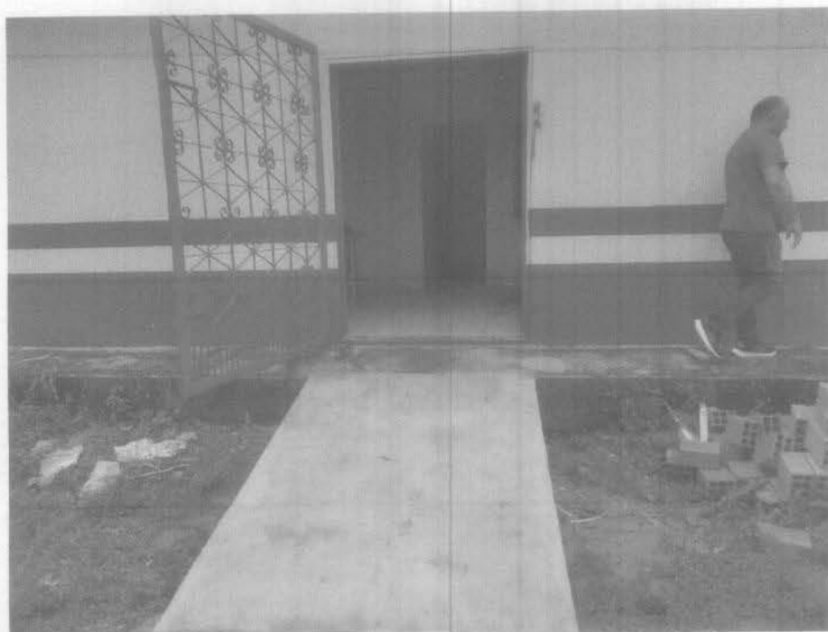
Imagem 3 – recuperação da calçada e pintura externa Fonte: Autora – 2023
