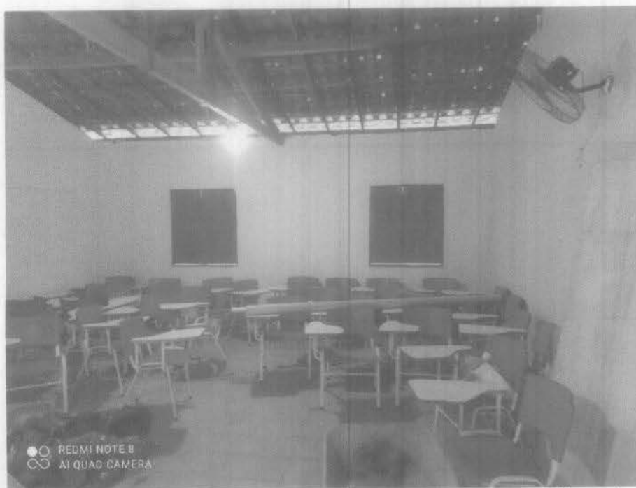
Imagem 6 – recuperação do reboco, pintura geral da área interna e retelhamento Fonte: Autora – 2023
