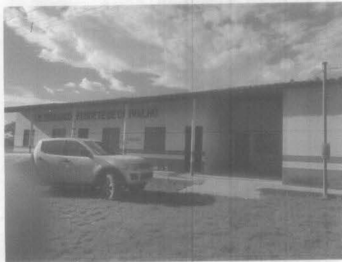
Imagem 1 – pintura da fachada, retalhamento. Fonte: Autora – 2023
