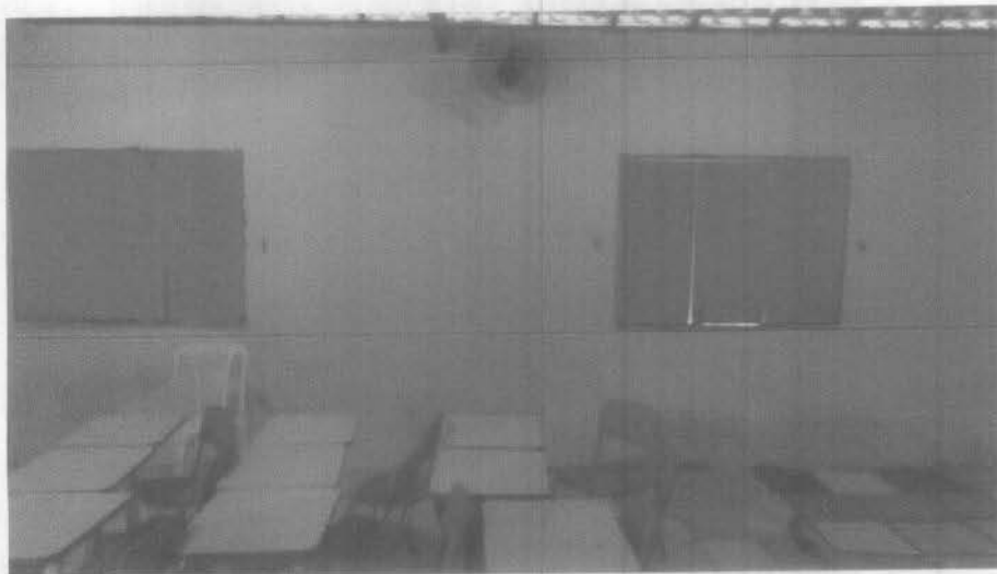
Imagem 3 – pintura interna e pintura das esquadrias. Fonte: Autora – 2023
