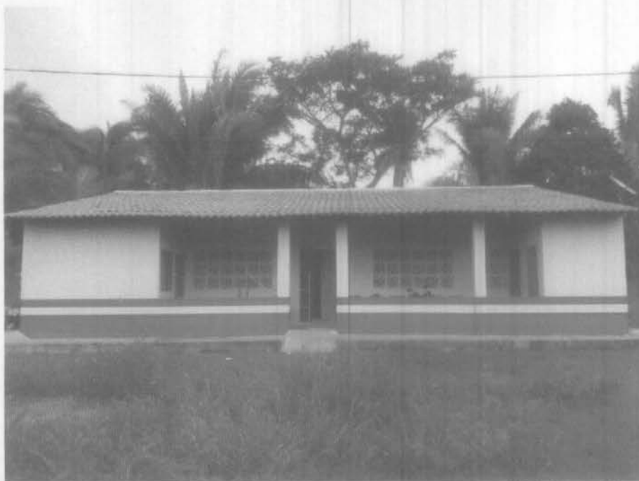
Imagem 2 – Pintura da fachada, recuperação telhado com substituição de 50% de madeira e calçada Fonte: Autora – 2023
