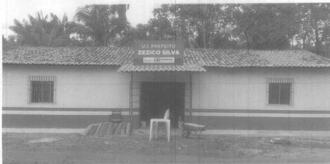
Imagem 1 – pintura da fachada, retalhamento e placa de ACM Fonte: Autora – 2023
