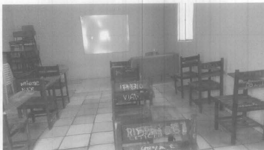
Imagem 5 – pintura interna e pintura das esquadrias Fonte: Autora – 2023
