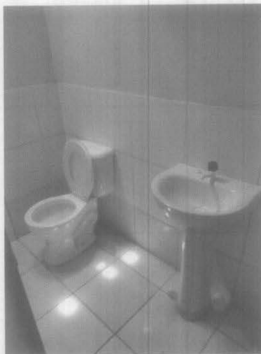
Imagem 6 – substituição e instalação vaso sanitário e lavatório Fonte: Autora – 2023
