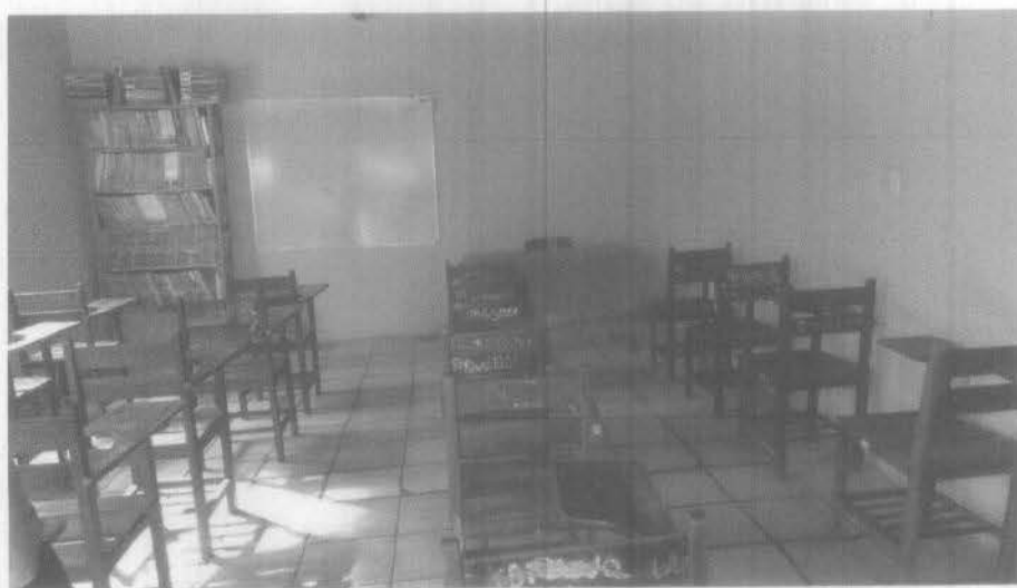
Imagem 2 – pintura interna e recuperação de ponto de tomadas. Fonte: Autora – 2023
