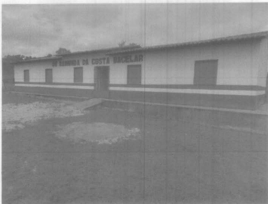
Imagem 1 – Pintura da fachada, recuperação telhado com substituição de 50% de madeira Fonte: Autora – 2023
