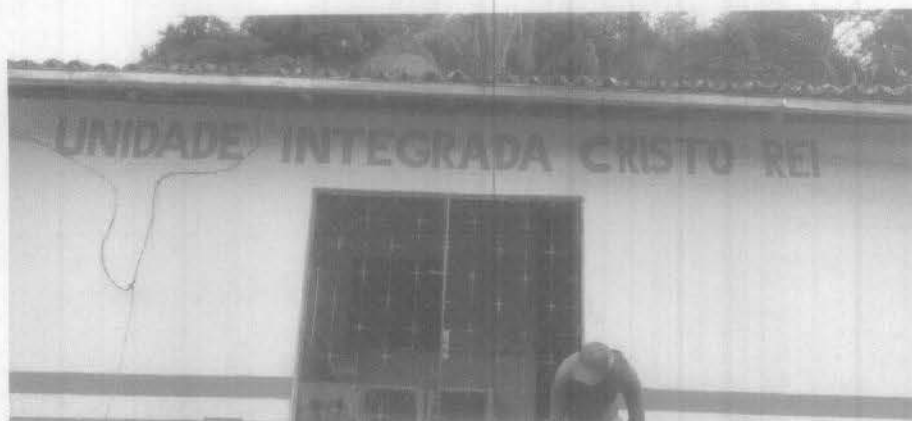
Imagem 2 – pintura externa da fachada Fonte: Autora – 2023
