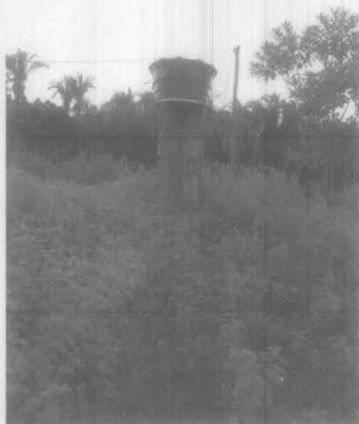
Imagem 6 – instalação de caixa d'água 1000L Fonte: Autora – 2023
