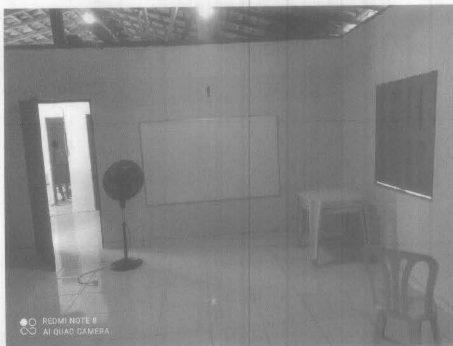
Imagem 4 – instalação de porta, pintura geral da área interna. Fonte: Autora – 2023
